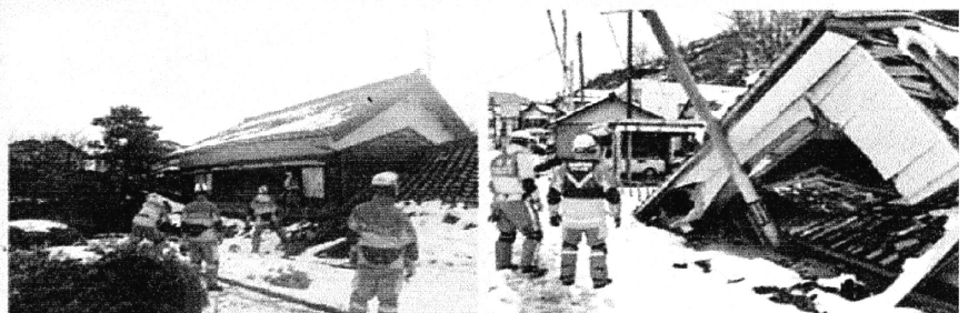
R6.1石川県（能登半島地震）派遣の状況
